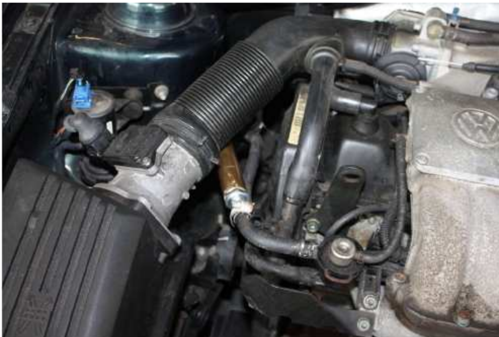
Bild 6: Ein innermotorischer Eingriff fand nicht statt, das System wurde lediglich außermotorisch in die Kraftstoffleitung eingebaut.
